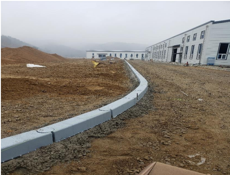
횡성군 일반산업단지 SJ Tech(주) 공장부지 내 도로 씨앤씨 도로 안전경계블록설치전경(2020.03)
